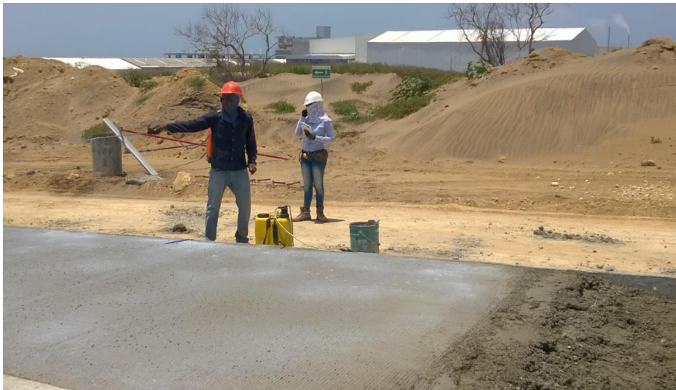
Fig. 14 – Aplicación controlada de compuesto de curado en un pavimento en Barranquilla
