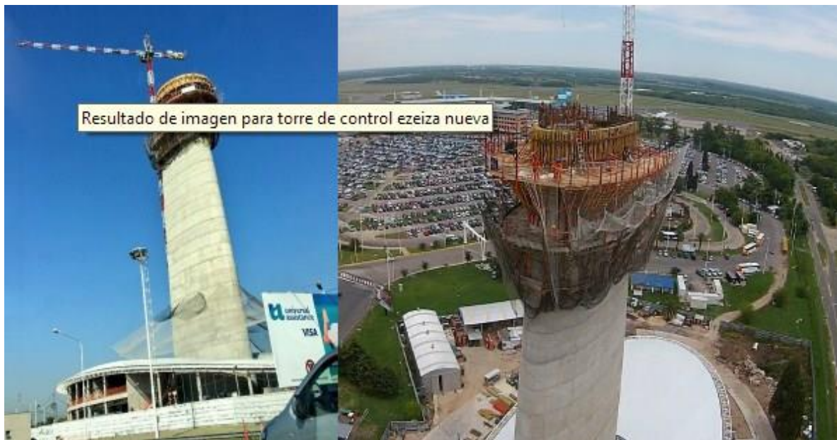
Fotografía 4. Nueva Torre de Control de Ezeiza
