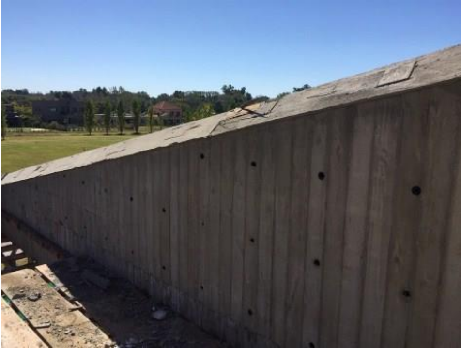
Fotografía 1. Tabique hormigón visto copiando tablas de madera
