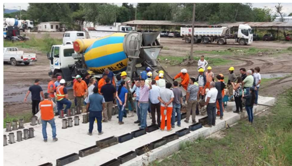
Figura 2: Día de hormigonado.
