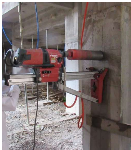
Figura 2: Extracción de testigos en pilar de hormigón armado.
