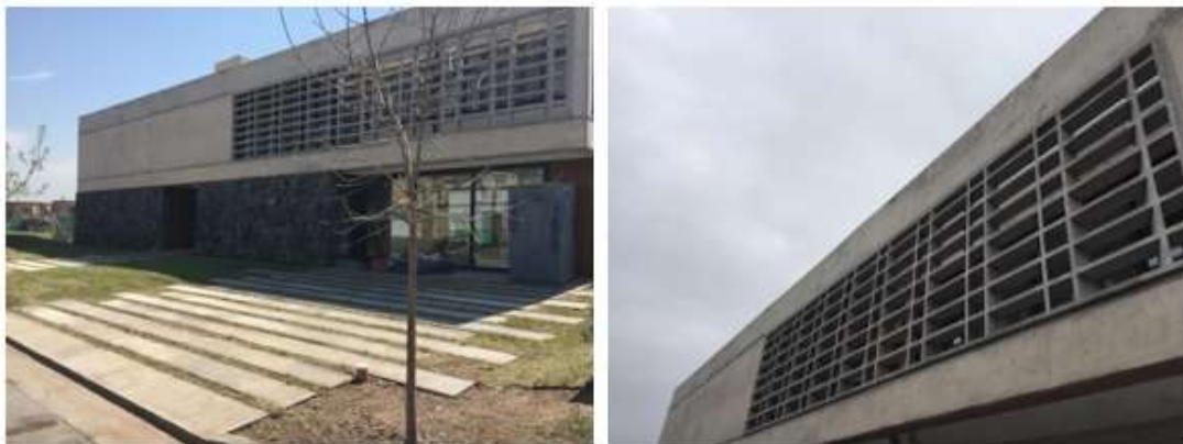
Figuras 6 y 7: Fachada con sistema prefabricado.
