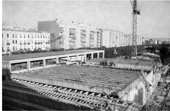
Figura 1 y 2: Proceso de fabricación y montaje de las vigas (imágenes archivo Barredo – Los huesos de Fisac. La búsqueda de la pieza ideal)
