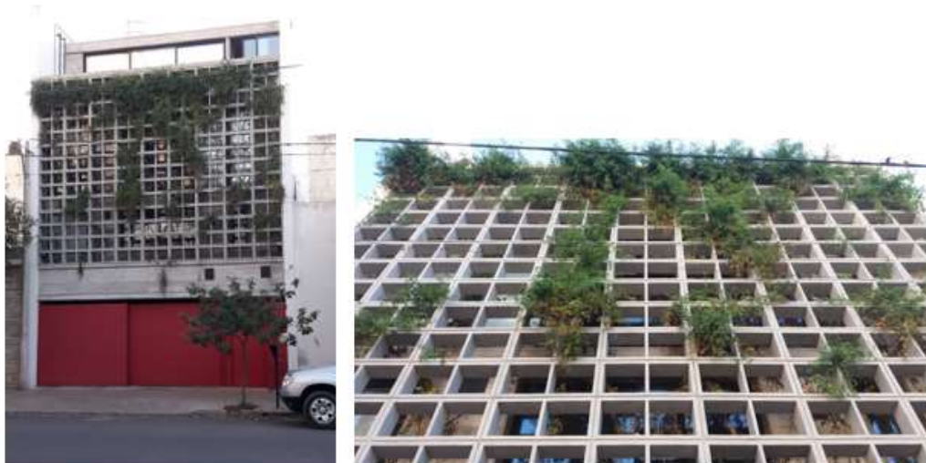
Figura 3: Fachada de la vivienda. Sistemas de módulos prefabricados.
