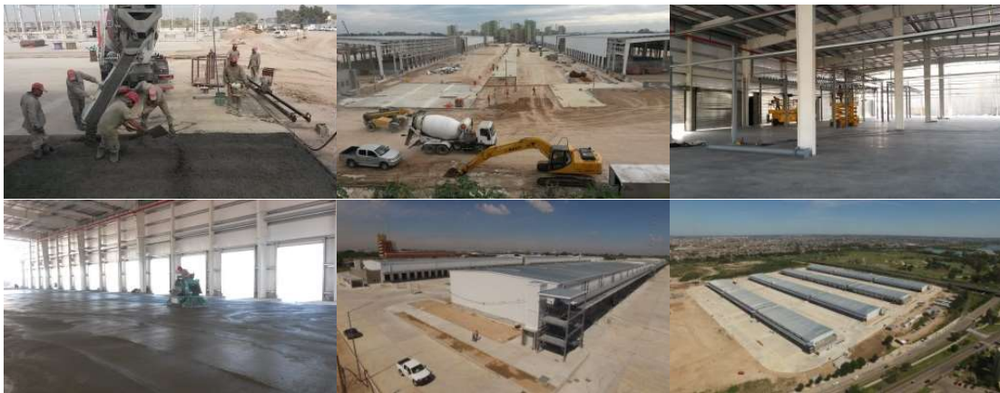
Figura 5: Construcción del pavimento en el Centro de Transferencia de Cargas de Buenos Aires empleando hormigones con macrofibras sintéticas.
