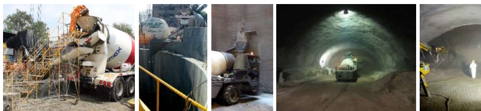
Figura 1: Procedimiento de colocación de revestimiento primario del túnel L-12.
