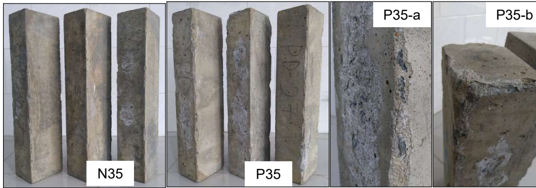
Figura 5: Aspecto visual general y en detalle de los hormigones en suelo con sulfato.
